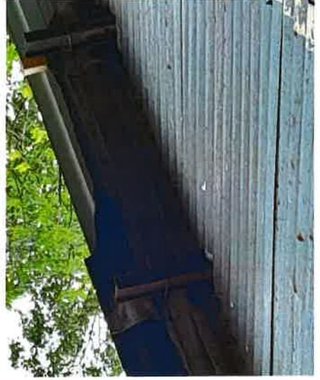
Toiture en plaques ondulées fibro-ciment Bâtiment 1 Bâtiment 3 / Bâtiment 4
