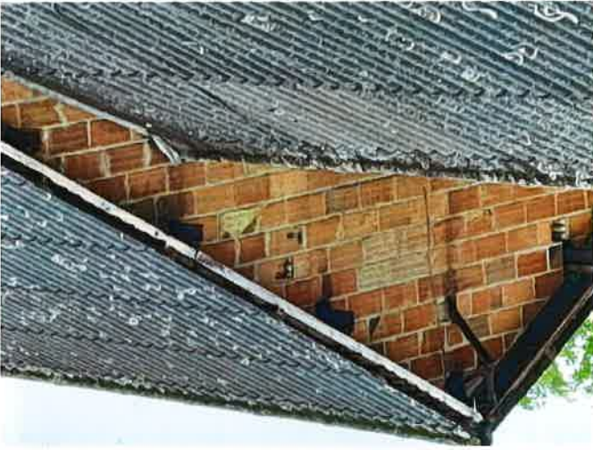
Toiture en plaques ondulées fibro-ciment Bâtiment 1 Bâtiment 3 / Bâtiment 4
