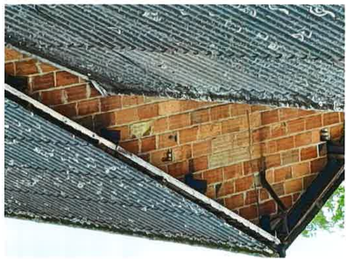
Toiture en plaques ondulées fibro-ciment Bâtiment 3 / Bâtiment 4
